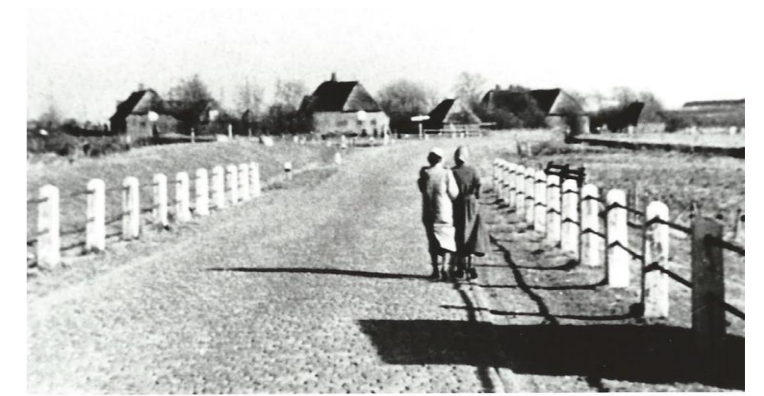
③ Befahrbarer Damm 1935 Einfahrt Wobbenbüll
