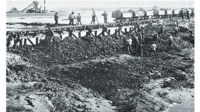
② Dämmung des Prieles/Tiefs vor Nordstrand
