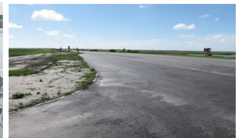
... und ④ die neue Zufahrt/Rampe 2017
