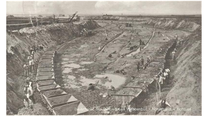
② Der Boden wird auf Loren verladen.
